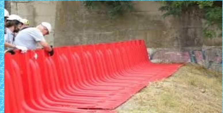
La parte orizzontale della barriera è spinta contro il terreno dalla pressione dell'acqua. Il fondo è dotato di solette in gomma cellulare per garantire l'aderenza al terreno.
